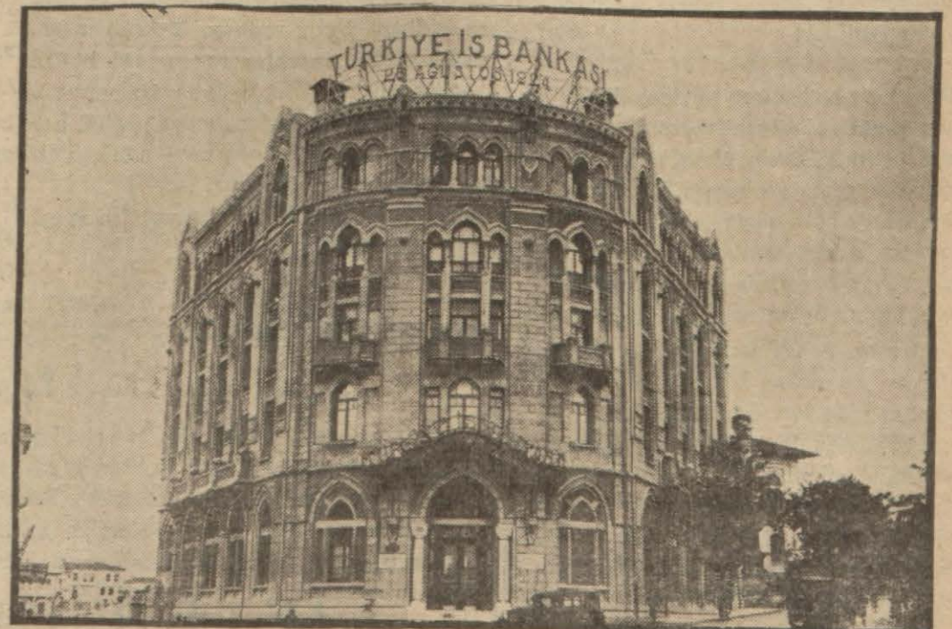
İş Bankası umûmî merkez binası (Yazısı 11 inci sayfada)
